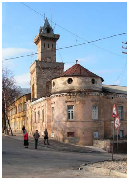
Здание Мещанской части. Современное фото
